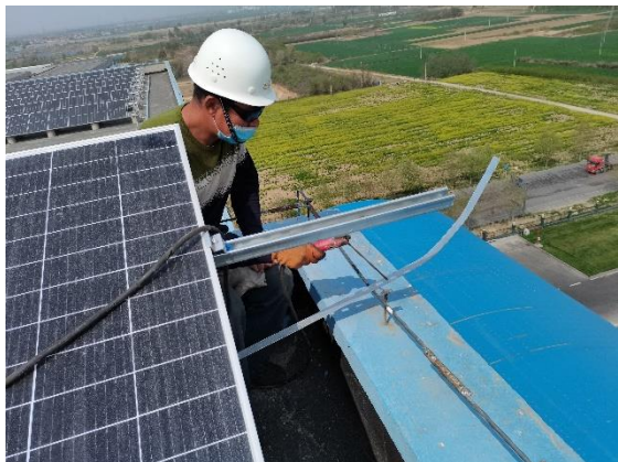
沙河厂区“制粉车间”接地与原避雷带焊接
