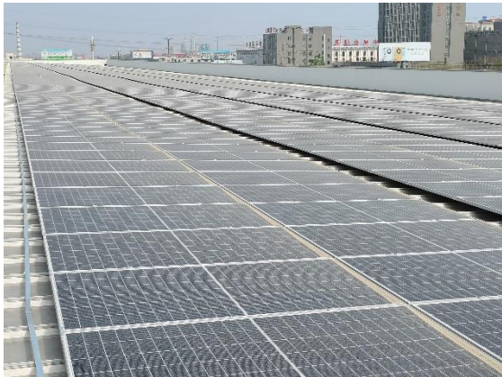
沙河厂区“挂面车间雨棚”屋顶成品雏形
