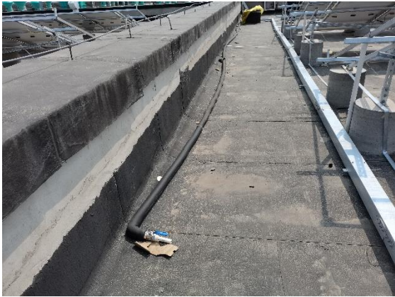
沙河厂区制粉车间清洗水管安装
