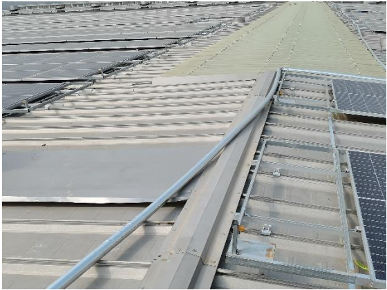
沙河厂区挂面车间清洗水管安装
