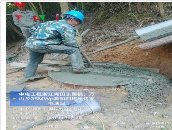
中电工程浙江青田东源镇，万山乡35MWp复和利用光伏发电项目 施工区域：青田县东源镇万山乡 施工内容：11号塔基浇筑混凝土4号 拍摄时间：2020.11.03 星期二 15:37 地点：未获取
