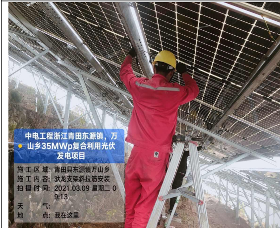
中电工程浙江青田东源镇，万山乡35MWp复合利用光伏发电项目 施工区域：青田县东源镇万山乡 施工内容：驮坑光伏区跨接线安装 拍摄时间：2021.03.09 星期二 16:09 天气：阴 14℃ 西北风3级 湿度 52% 地点：丽水市·驮磨背
