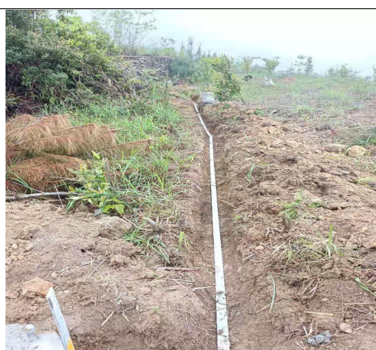
驼龙区增容部分接地扁钢焊接
