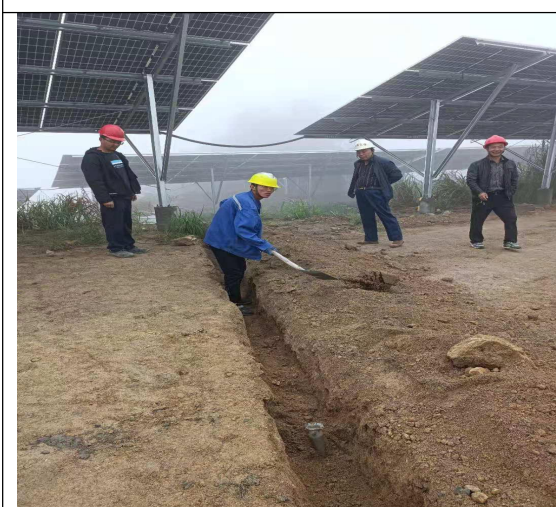
驼龙区增容部分接地沟开挖
