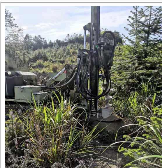
龙须光伏区桩基打孔
