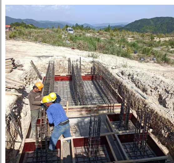
龙须光伏区 S1 箱变基础钢筋绑扎
