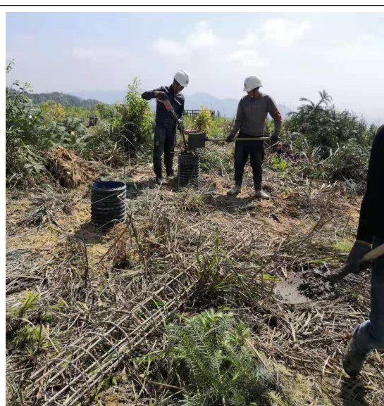
龙须光伏区桩基
