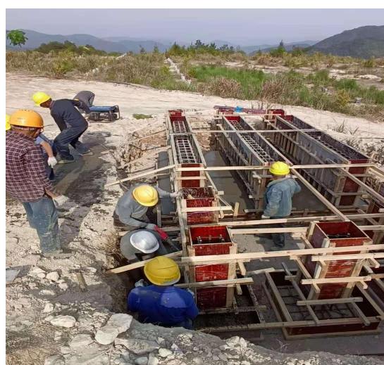
龙须光伏区 S1 箱变基础浇筑混凝土
