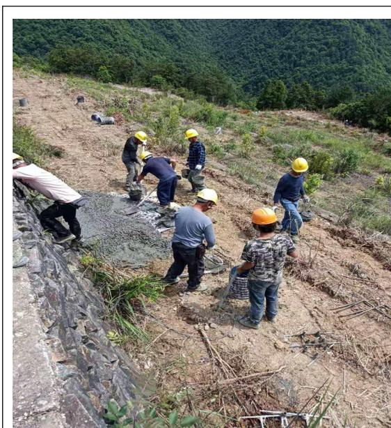
龙须区桩基浇筑混凝土
