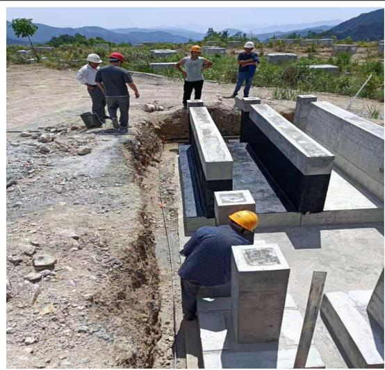
箱变基础接地环网施工
