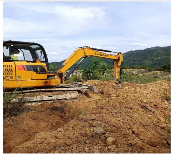
龙须区接地环网接地沟开挖
