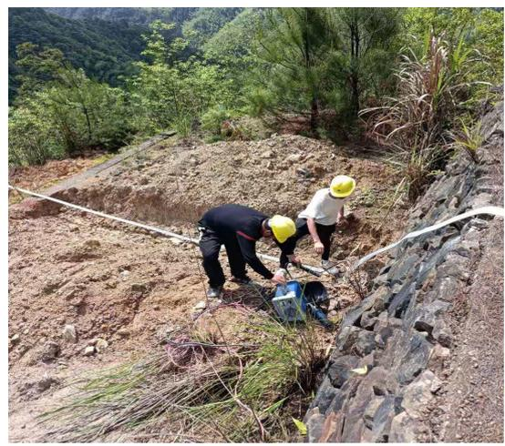
龙须区接地环网接地扁铁焊接
