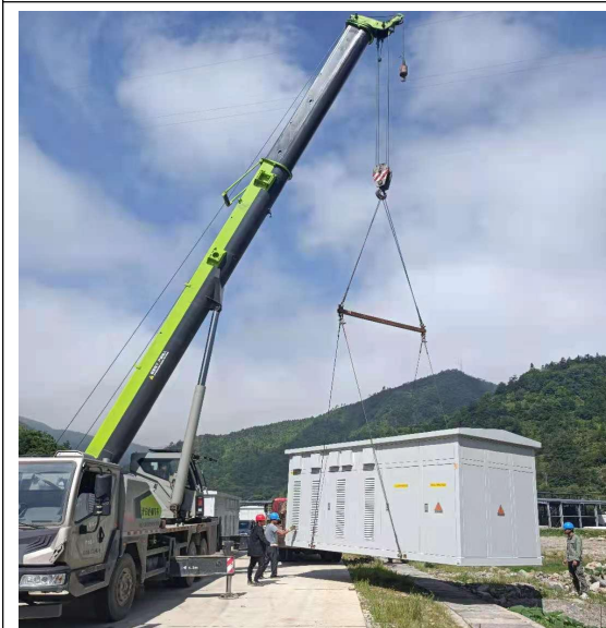
龙须区箱变设备吊运
