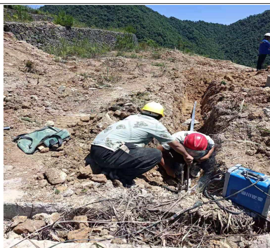
龙须区接地扁铁焊接
