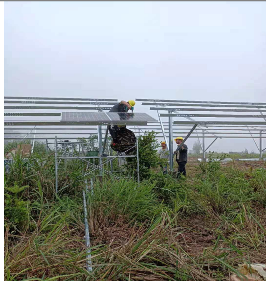
龙须区组件安装
