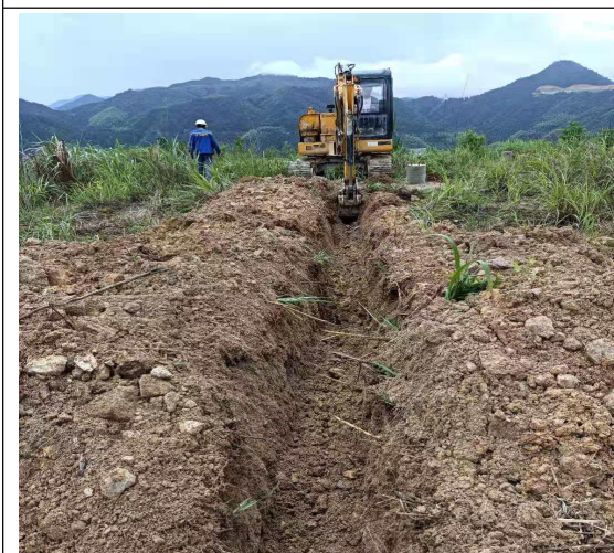
龙须区接地沟开挖
