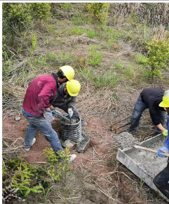
龙须区桩基浇筑混凝土
