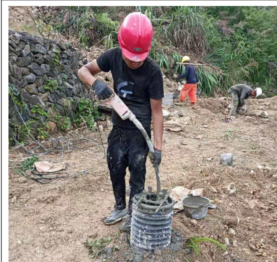
龙须区桩基浇筑混凝土
