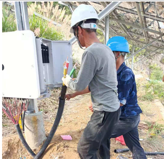
龙须区逆变器低压电缆端接
