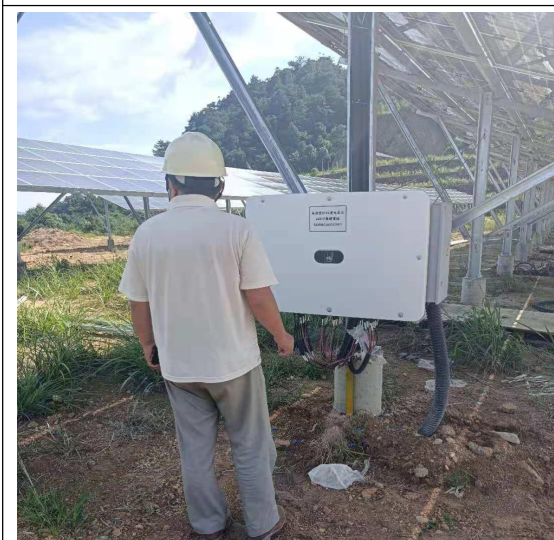
对龙须区直流电缆线消缺进行检查
