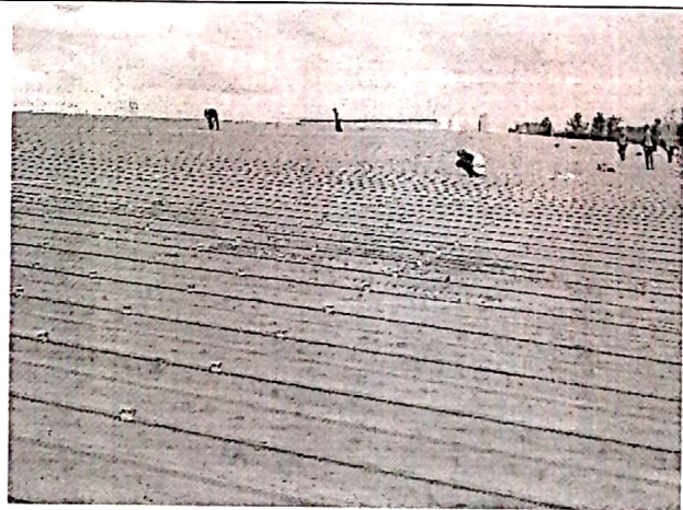
仓库屋面夹具安装
