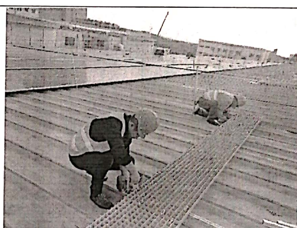
仓库屋面检修通道安装
