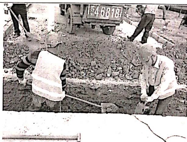
过路电缆沟施工
