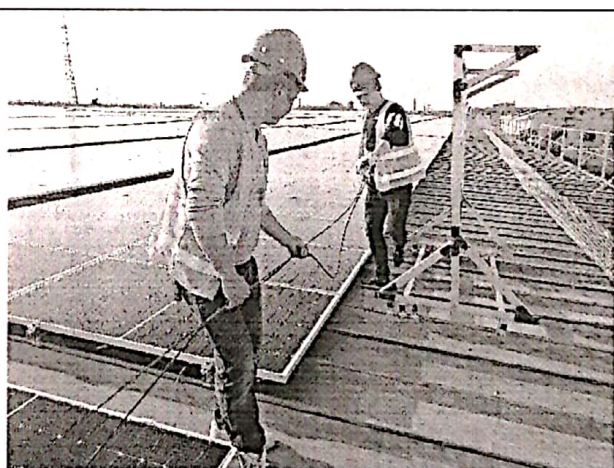
彩钢瓦屋面组件安装
