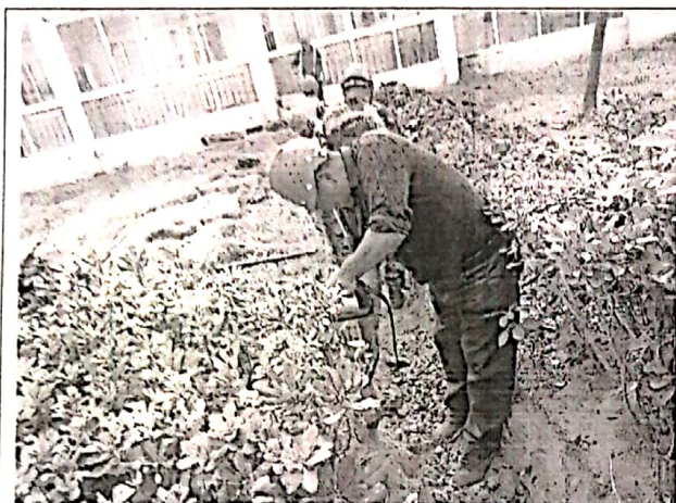
场内电缆沟开挖
