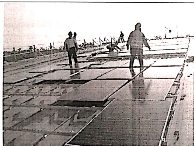
彩钢瓦屋面组件安装
