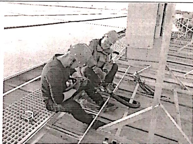
至逆变器电缆施工
