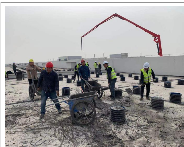
支架基础混凝土水泥墩浇筑
