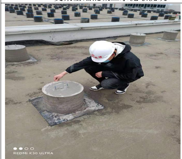
支架基础混凝土水泥墩
