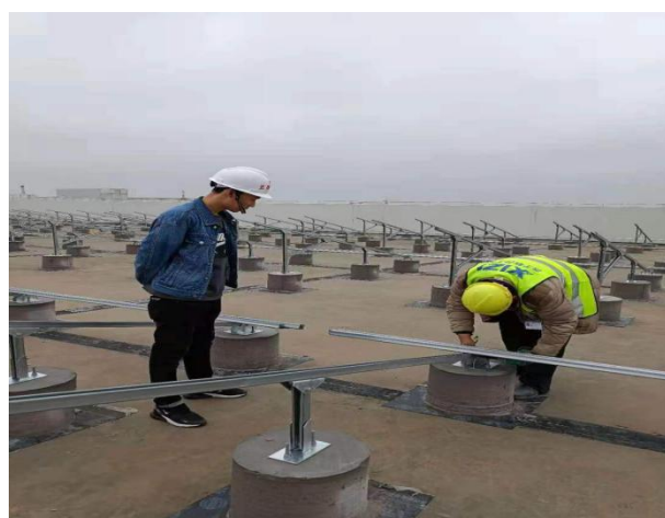
支架安装检查
