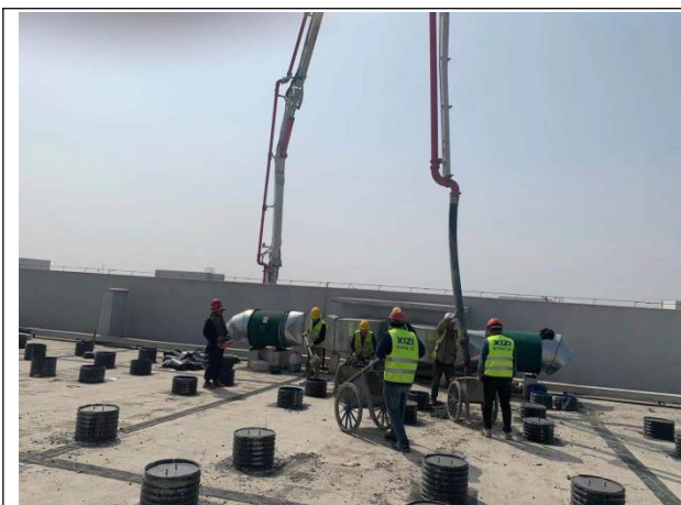
支架基础混凝土水泥墩浇筑
