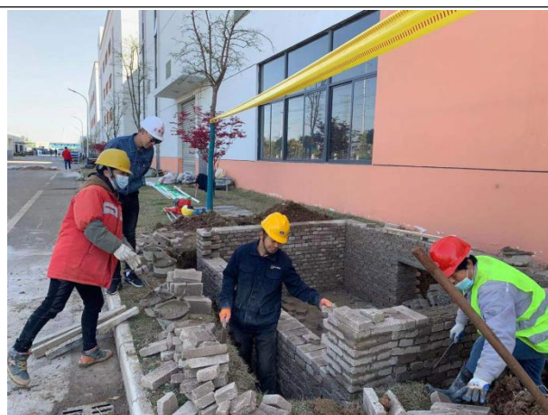
箱变基础砌筑
