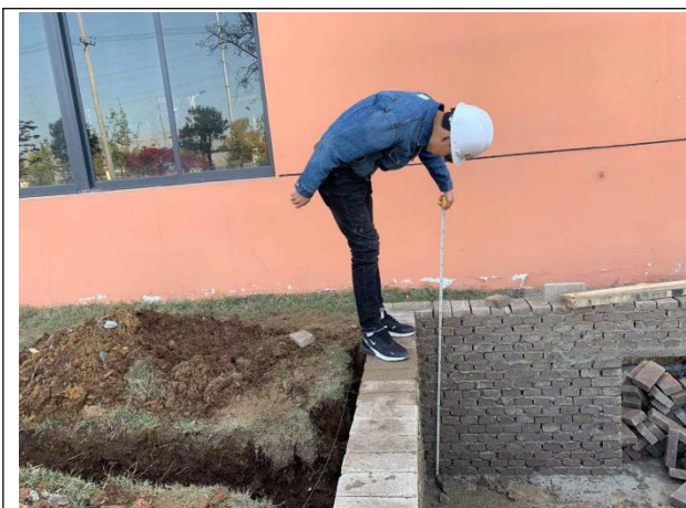
检查箱变基础
