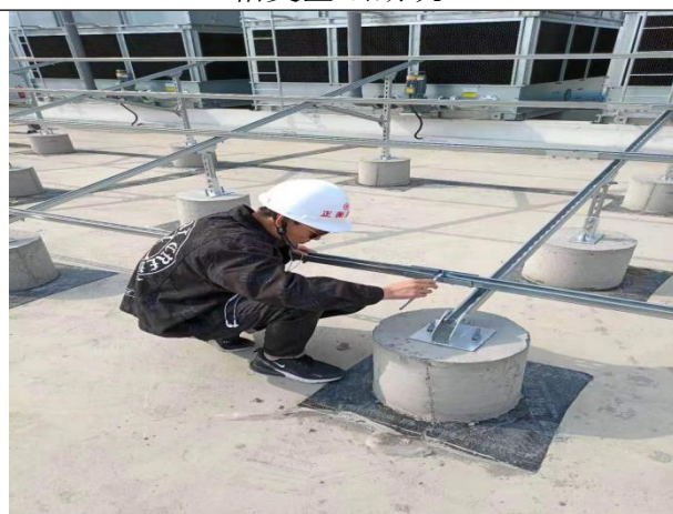
检查支架材料厚度
