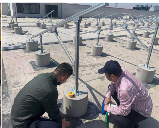
建设单位对现场检查
