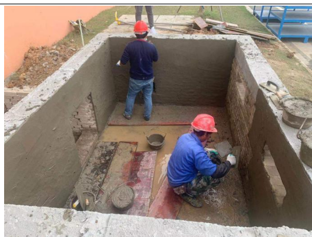
箱变基础抹灰
