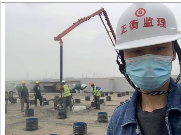
支架基础浇筑
