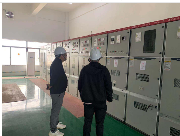
与业主检查配电室
