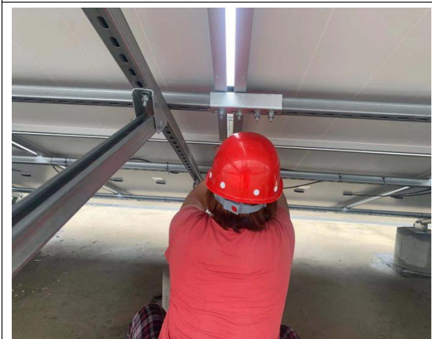
接地小黄线安装
