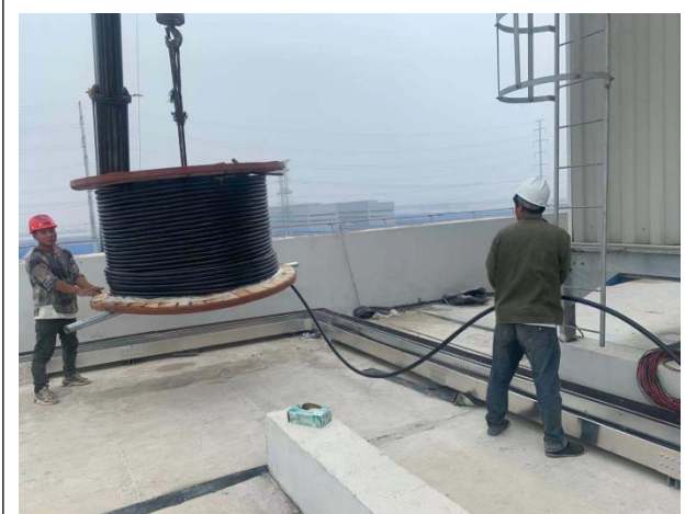
交流电缆敷设
