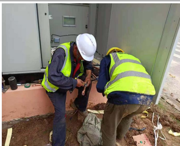
高压电缆头制作
