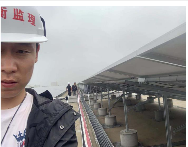
交流电缆敷设检查
