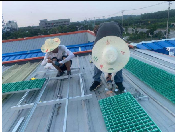
运维通道安装
