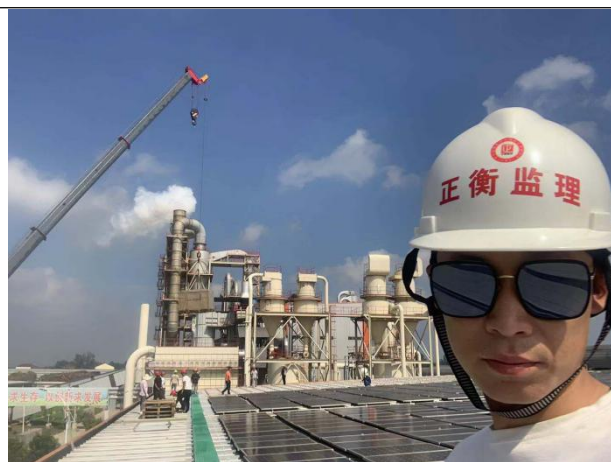
吊装组件安全旁站
