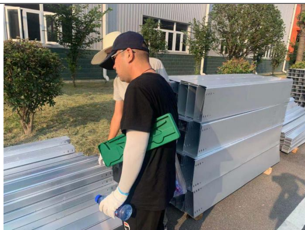
协同业主对桥架材料到货检查
