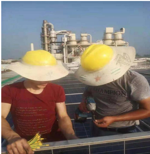
接地黄绿线安装
