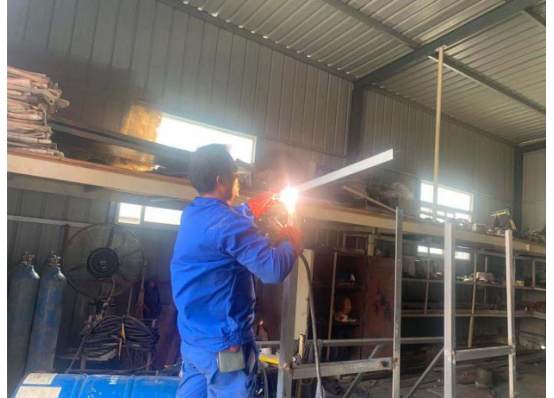
逆变器支架制作
