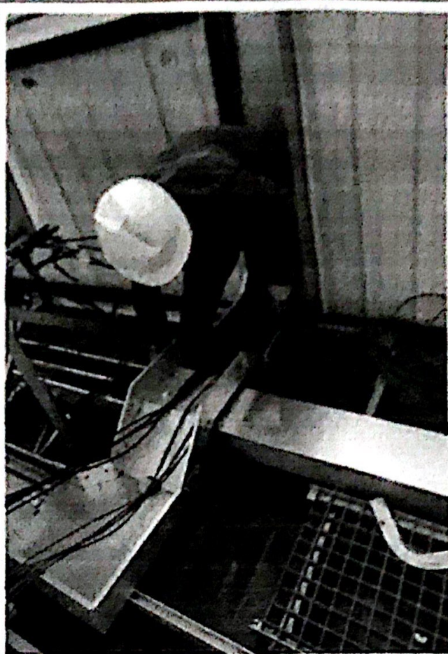
B2 逆变器桥架安装
