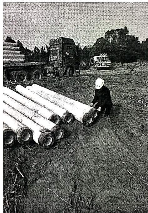
进场管桩检查
