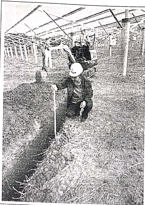
22#区接地网沟检查
