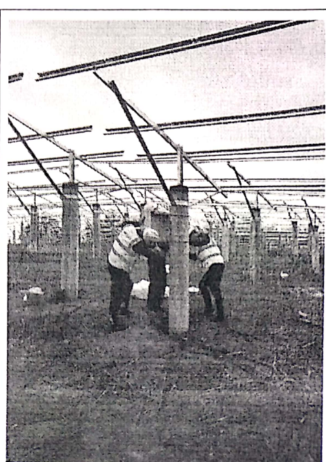
23#区汇流箱安装施工
