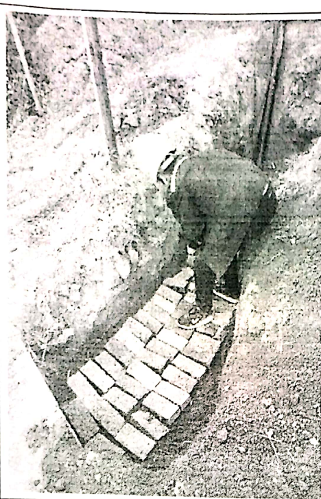
21#区-1#区箱变电缆沟铺砖
