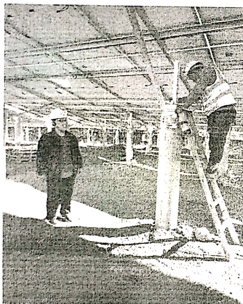
23#区桩头防腐检查
