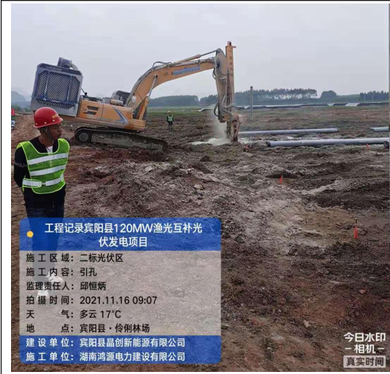
二标段光伏区桩基引孔、打桩
