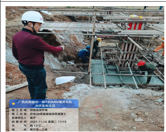
线路 3#塔基基础浇筑砼
