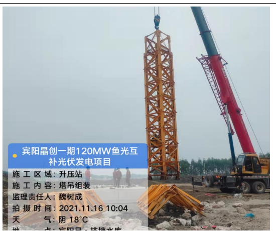
升压站塔吊安装
