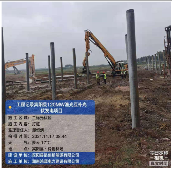
二标段光伏区桩基引孔、打桩
