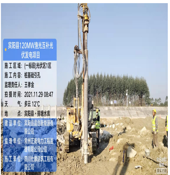
一标段桩基引孔
