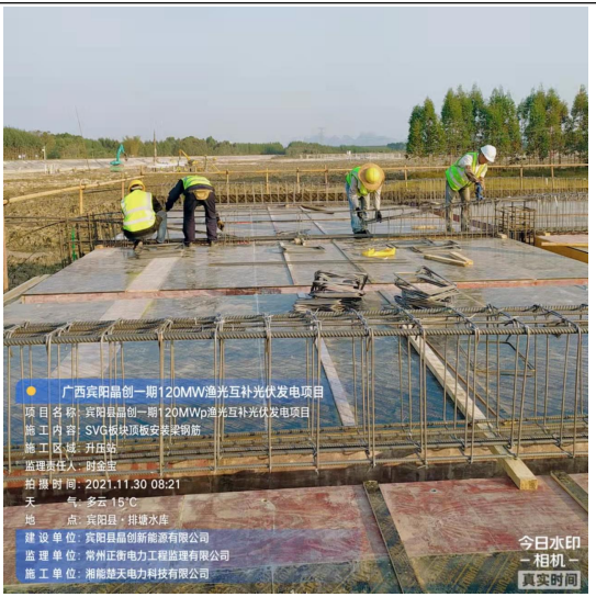
升压站 SVG 板块基础平台施工
