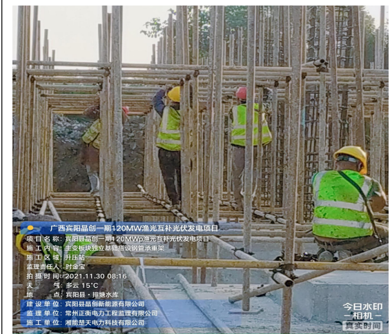
升压站主变基础平台支撑家脚手架搭设
