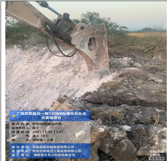
外线 4 号塔基基础开挖
