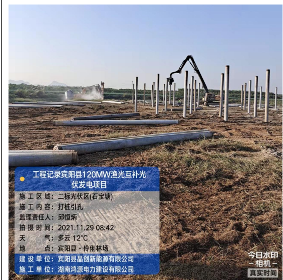
二标段桩基打桩
