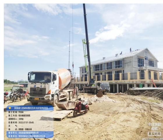
升压站综合楼屋面防水保护层浇筑混凝土
