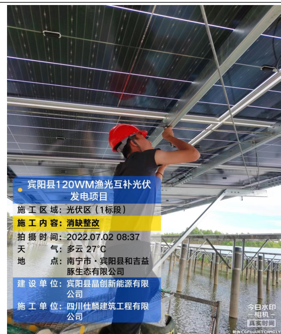
一标段光伏区消缺整改
