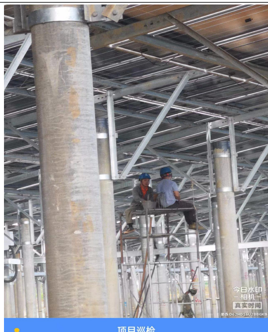
二标段光伏区消缺整改
