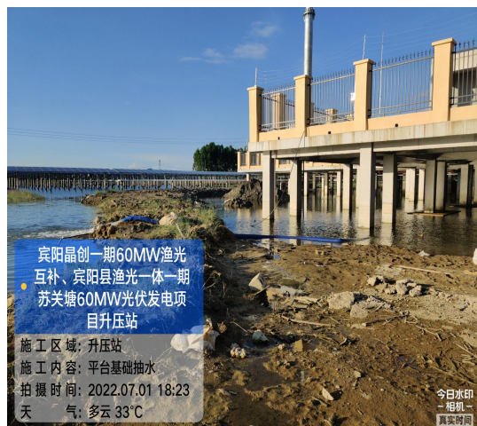
升压站基础平台抽水
