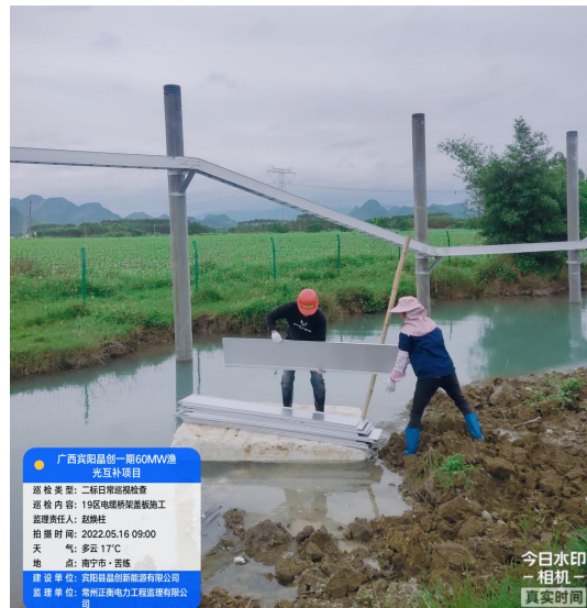
二标段光伏区桥架盖板安装
