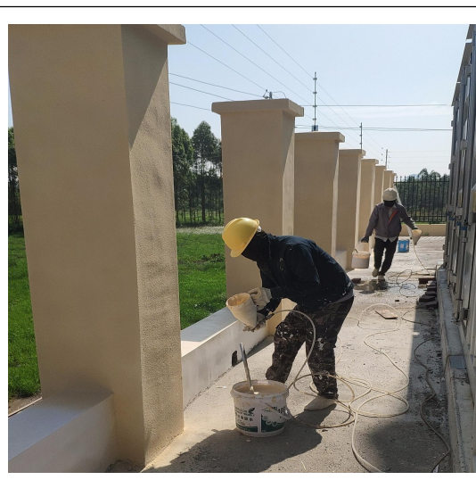
升压站围墙真石漆喷涂
