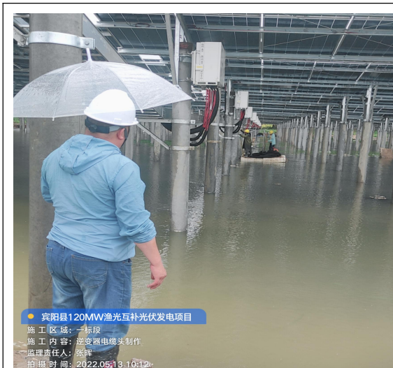
一标段逆变器电缆端接
