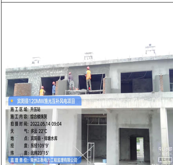
升压站综合楼外墙抹灰
