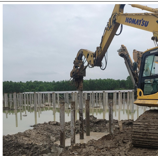
一标段 30 区桩基打桩
