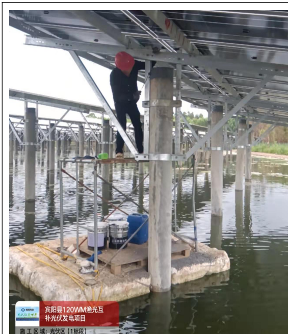
一标段光伏区桩头除锈刷漆
