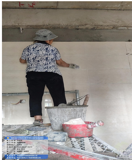
综合楼厨房墙面砖施工
