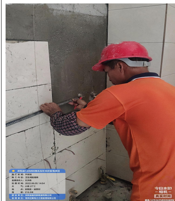
升压站卫生间墙面砖施工
