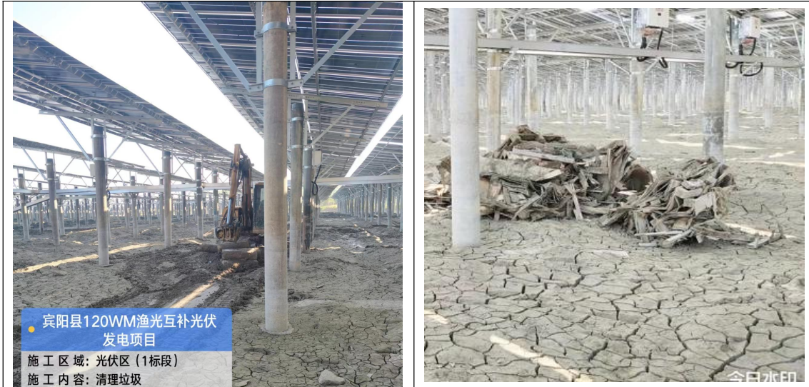
光伏区垃圾清理
