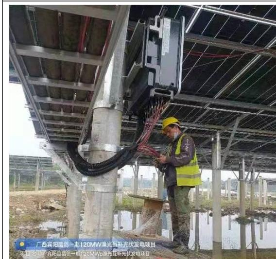
一标段逆变器电缆线端接
