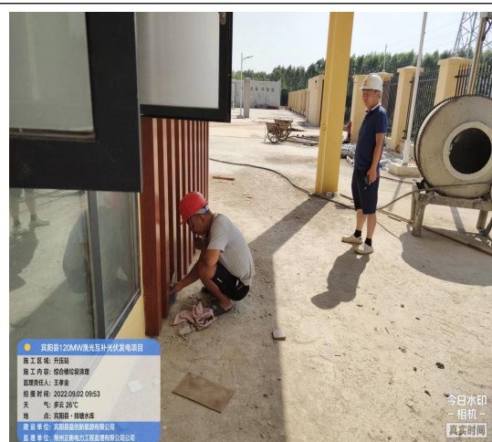
升压站垃圾清理
