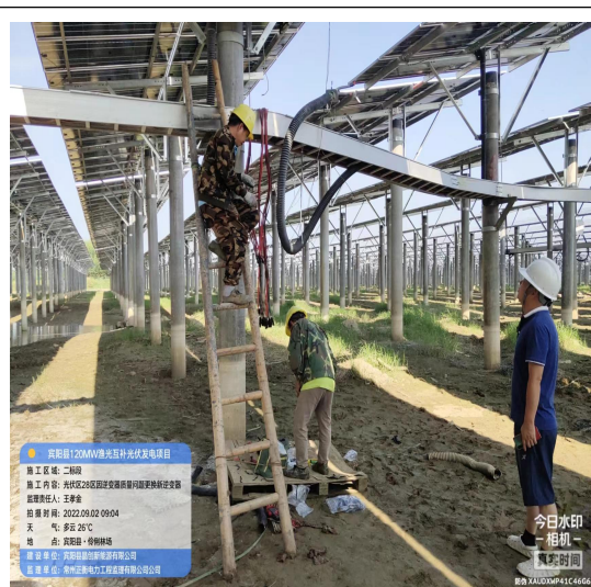
二标段光伏区逆变器电气消缺
