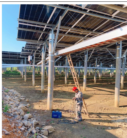
二标段光伏区下沉管桩接桩焊接
