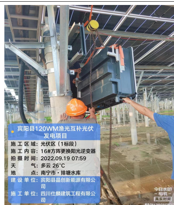
一标段光伏区逆变器消缺
