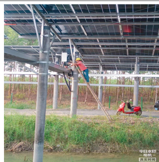
二标段光伏区桥架接地消缺
