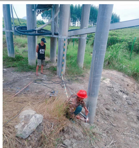
二标段光伏区箱变接地消缺
