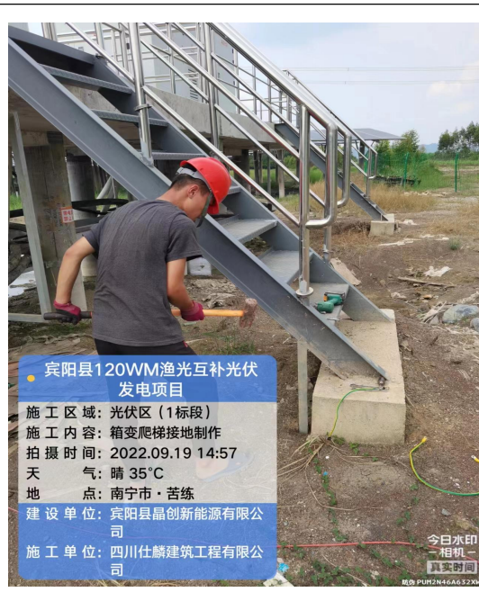
一标段光伏区爬梯接地消缺
