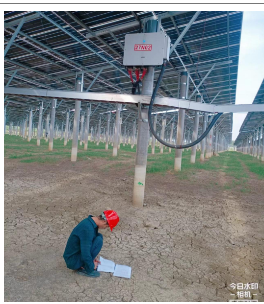
二标段光伏区质量自检
