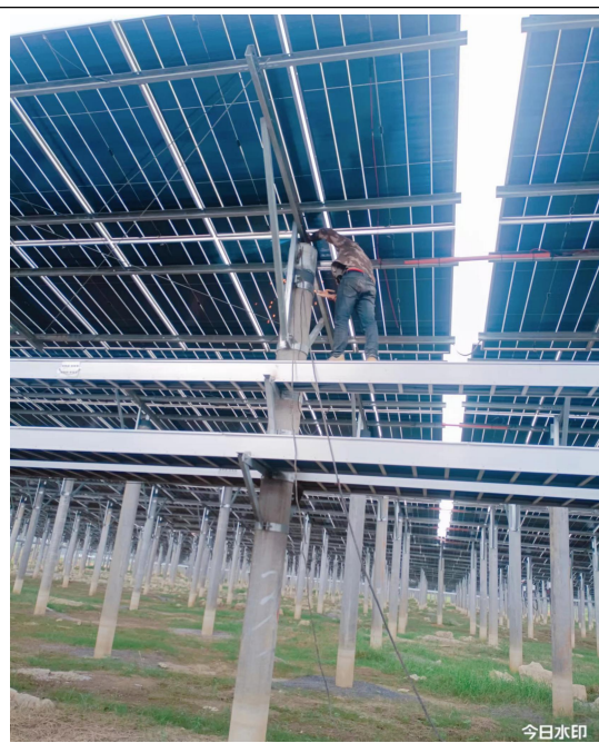
二标段光伏区下沉管桩接桩焊接
