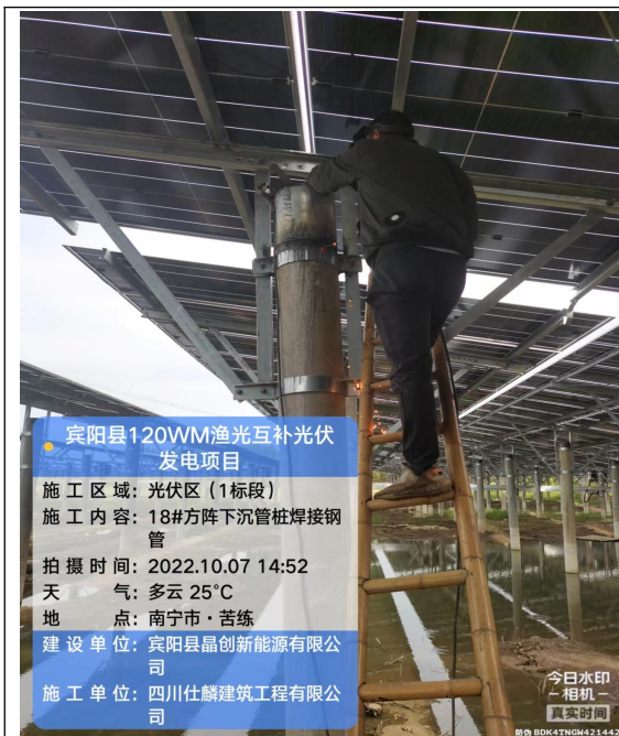
一光伏区下沉管桩接桩焊接
