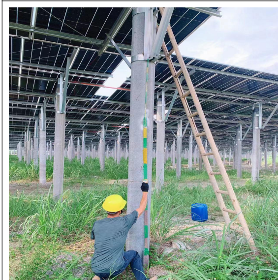
二标段光伏区接地消缺
