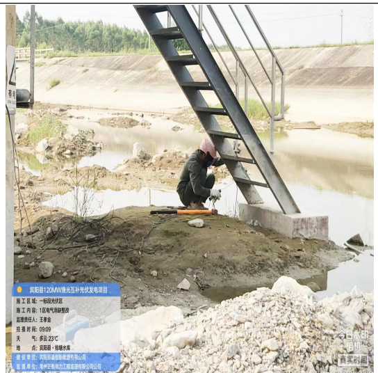
一标段光伏区爬梯接地消缺
