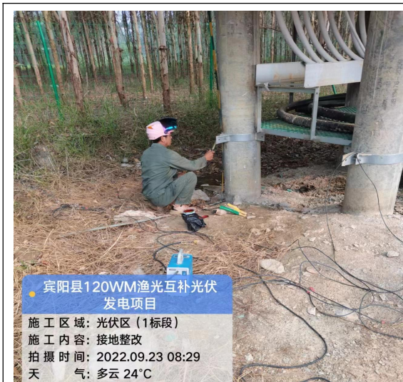
一标段光伏区箱变接地消缺
