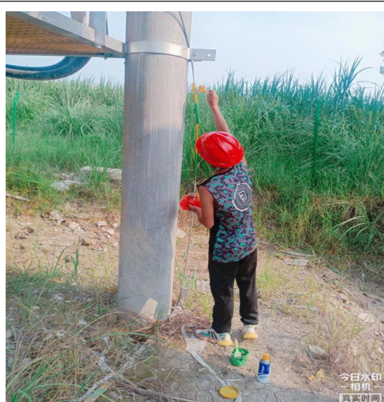
二标段光伏区箱变接地消缺
