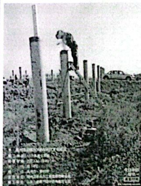
桩头支架立柱焊接
