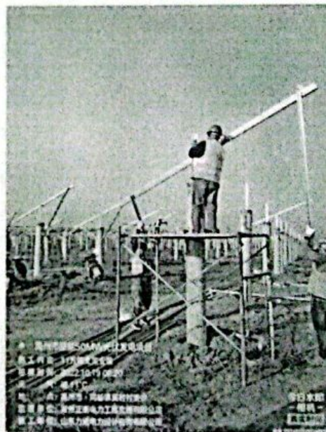
光伏支架安装
