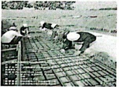
二次预制舱钢筋绑扎
