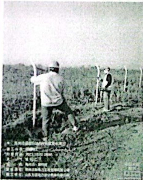
围栏安装间距检查
