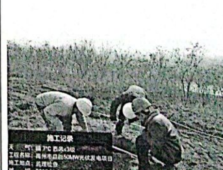
光伏区围栏基础检查
