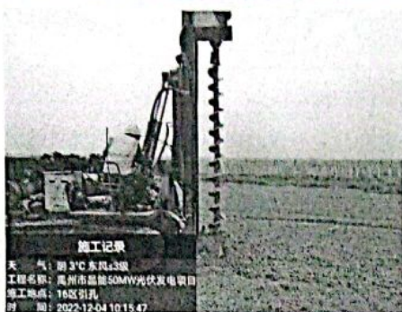
管桩基础引孔作业
