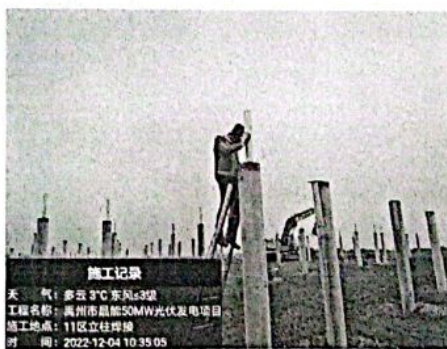
11#光伏方阵桩头立柱焊接
