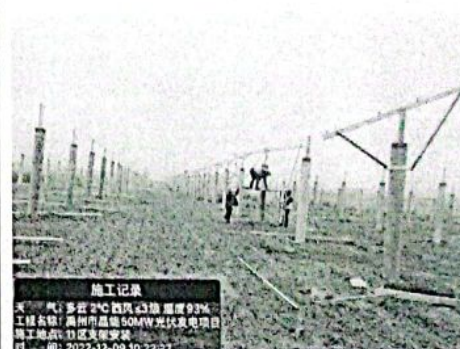
11#光伏方阵支架安装
