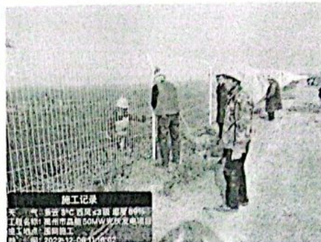
光伏区围栏安装
