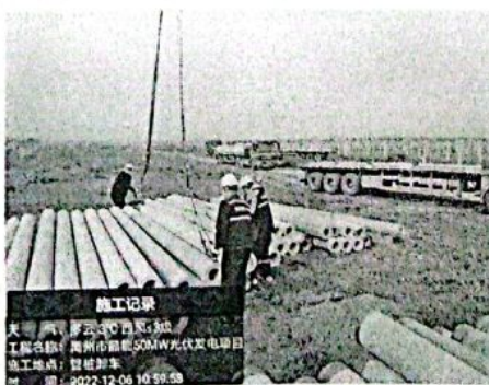
预制管桩到场
