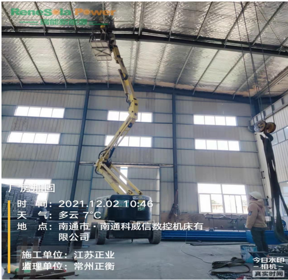
现场检查厂房加固
