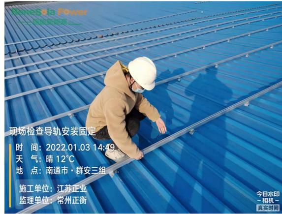
检查导轨安装固定
