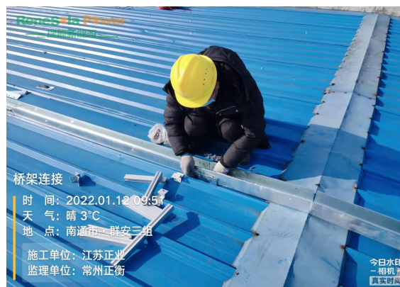
电缆桥架连接固定
