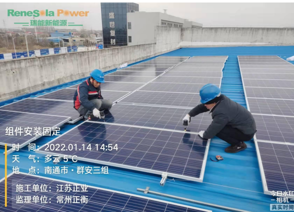
组件安装固定
