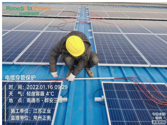
直流电缆穿管保护
