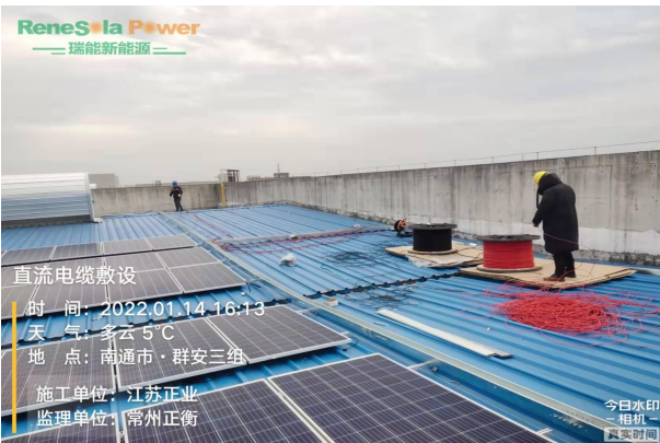
直流电缆敷设
