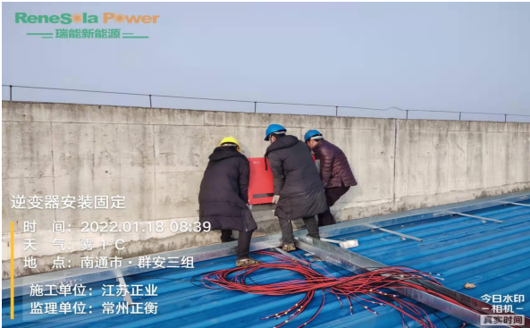
光伏逆变器安装
