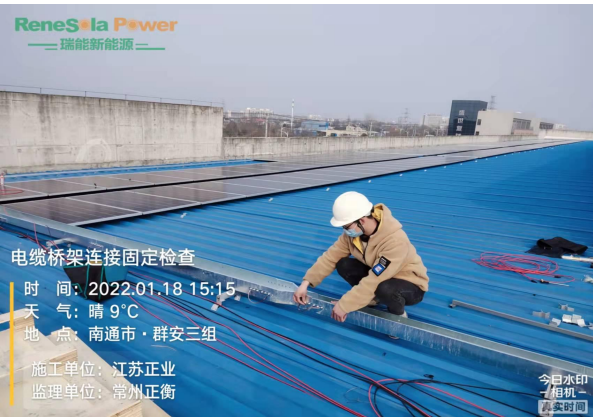
现场检查电缆桥架连接固定
