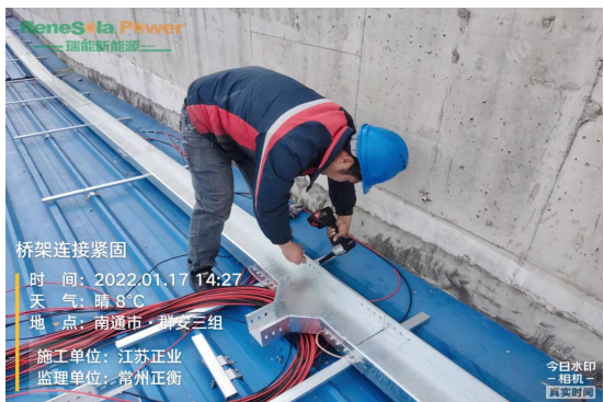
电缆桥架连接固定
