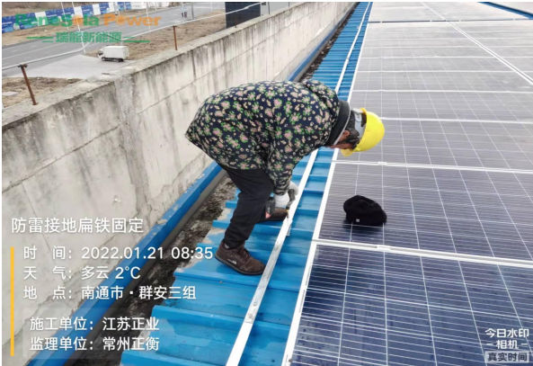
防雷接地扁铁固定
