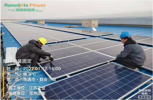
组件安装固定
