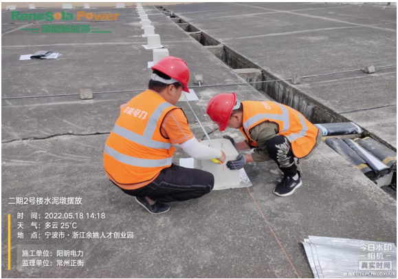
水泥墩倒运摆放
