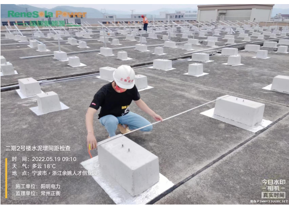
水泥墩间距检查
