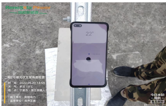
光伏支架角度检查
