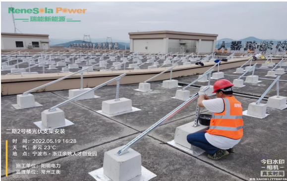
光伏支架安装
