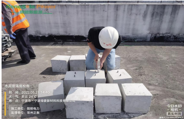
水泥墩强度等级检查
