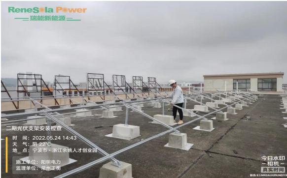
光伏支架安装检查
