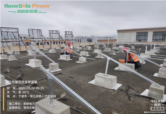
光伏支架安装
