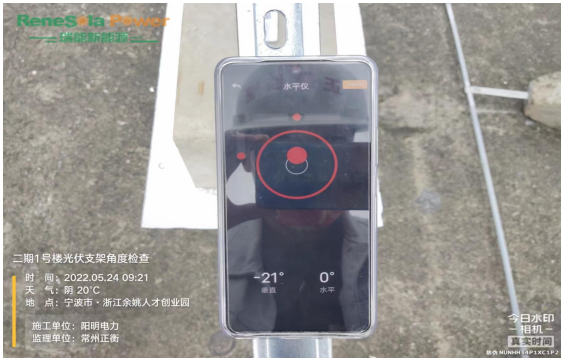
光伏支架角度检查
