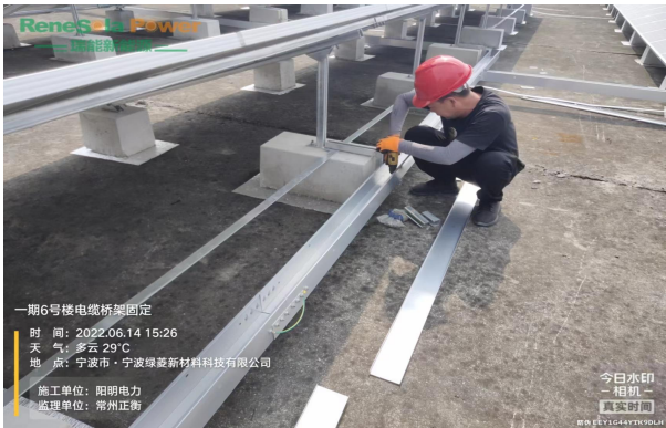
电缆桥架固定
