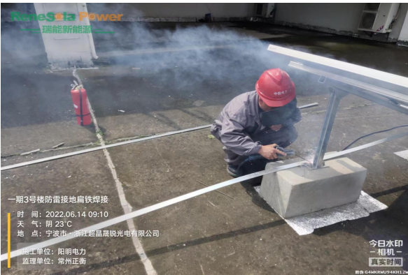
防雷接地扁铁焊接
