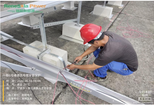
直流电流敷设穿管保护
