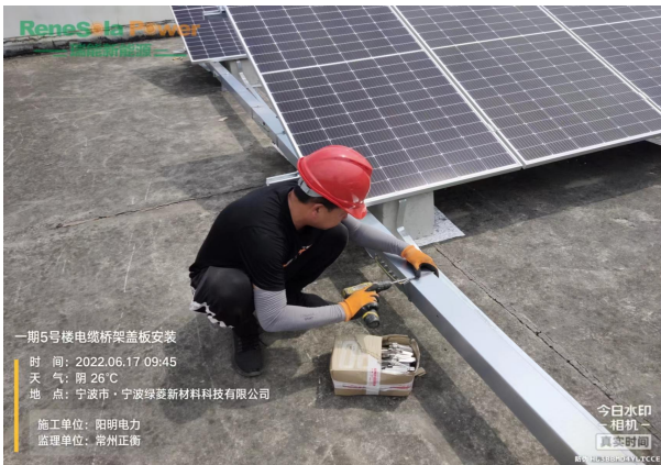
电缆桥架盖板安装固定
