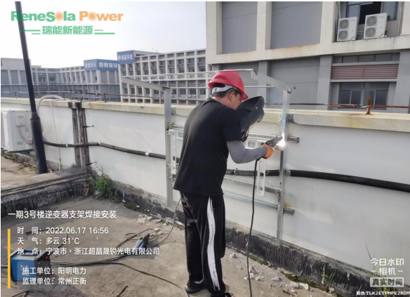
光伏逆变器支架焊接固定
