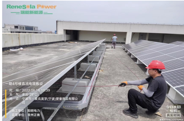
直流电缆敷设
