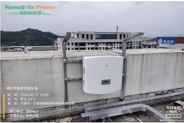
光伏逆变器安装
